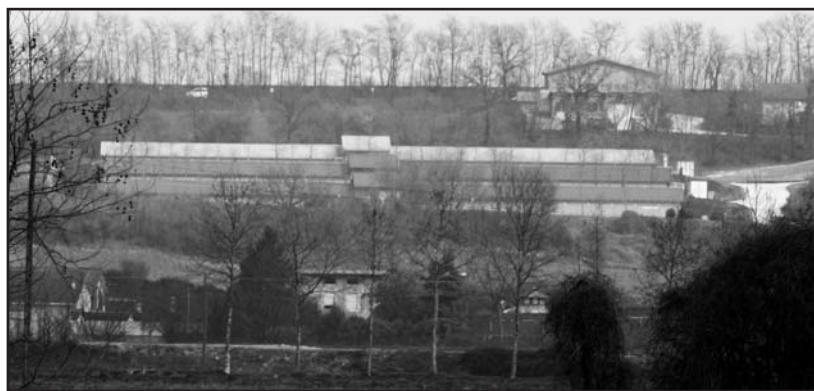
Due nuovi capannoni realizzati dopo il 2001.
